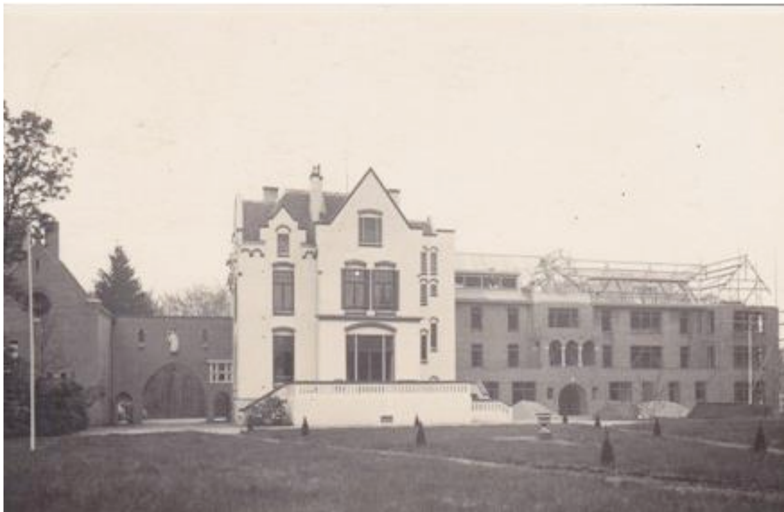
De nieuwe kloostervleugel in aanbouw, rond 1934(bron: mijnarnhem.nl)
