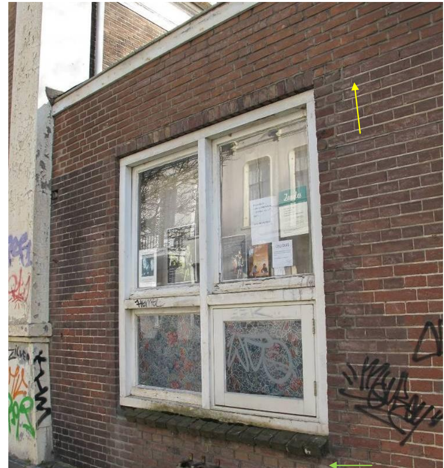
Zicht op de voorgevel van de rechter zijbeuk met een jonge vensteropening uit 1957 met bakstenen lekdoorpel (groene pijl) en rollaag in jongere steen en een in afwijkend metselwerk in 1956 opgehoogde bovenzijde (gele pijl). Foto FH MAB 2013
