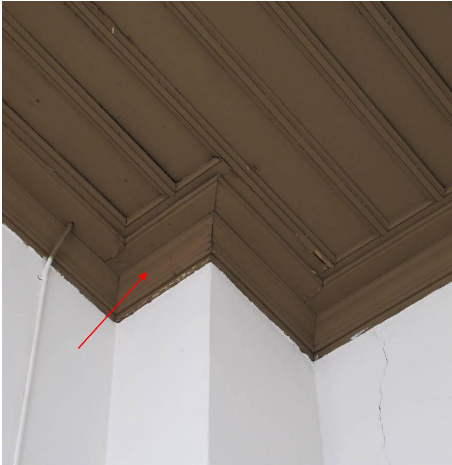
Doorlopende omlijsting rond het omstreeks 1910 recht geplaatste rookkanaal in het tweede lokaal rechts. Foto FH MAB 2013
