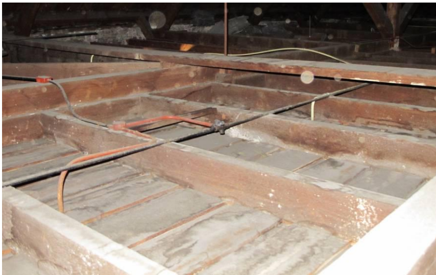
Plafondconstructie, Foto FH MAB 2013
