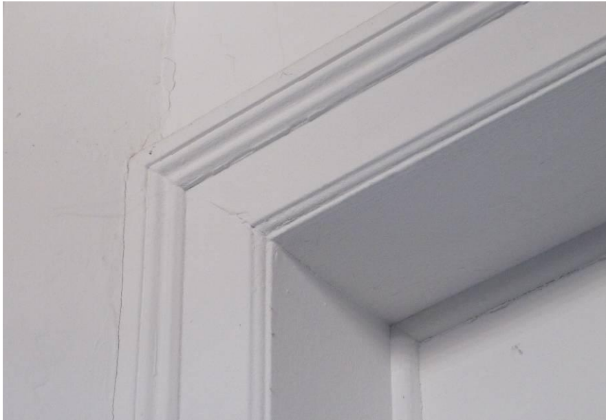
Detail deurlijst dichtzetting middenmuur. Foto FH MAB 2013
