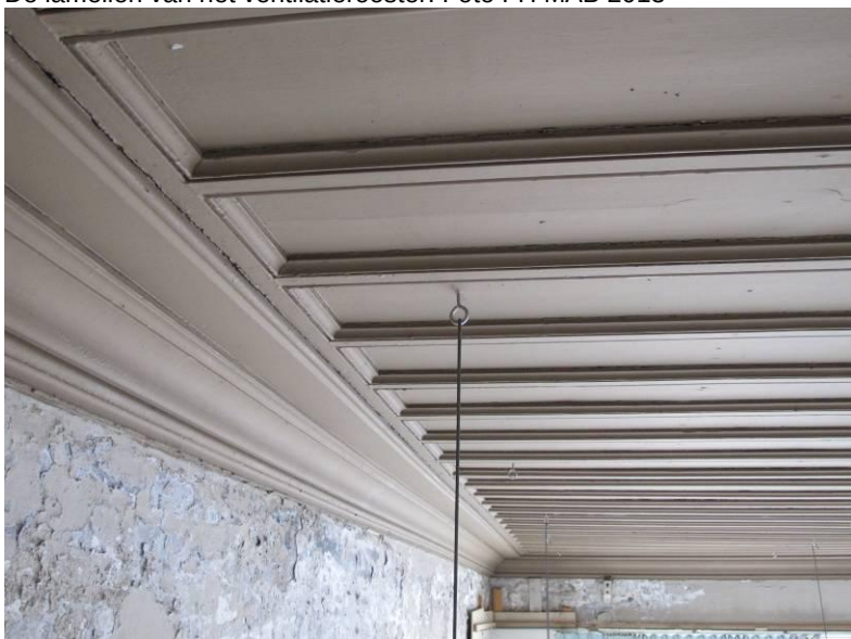
Plafond in het lokaal links achter. Foto FH MAB 2013
