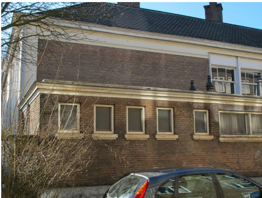
Achterzijde linker zijgevel hoofdgebouw. Foto FH MAB 2013
