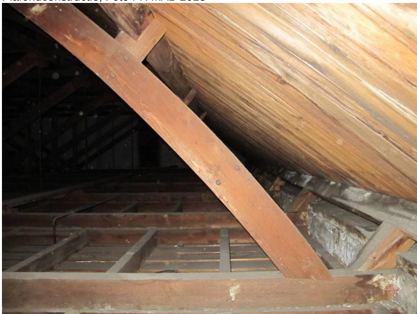
Aansluiting met keep van een schenkelspant in de trek balk. Foto FH MAB 2013
