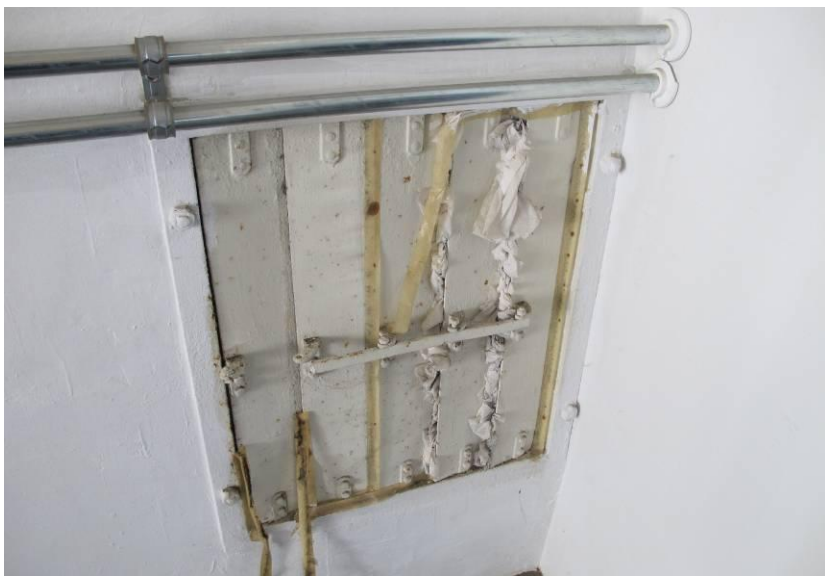
De lamellen van het ventilatierooster. Foto FH MAB 2013
