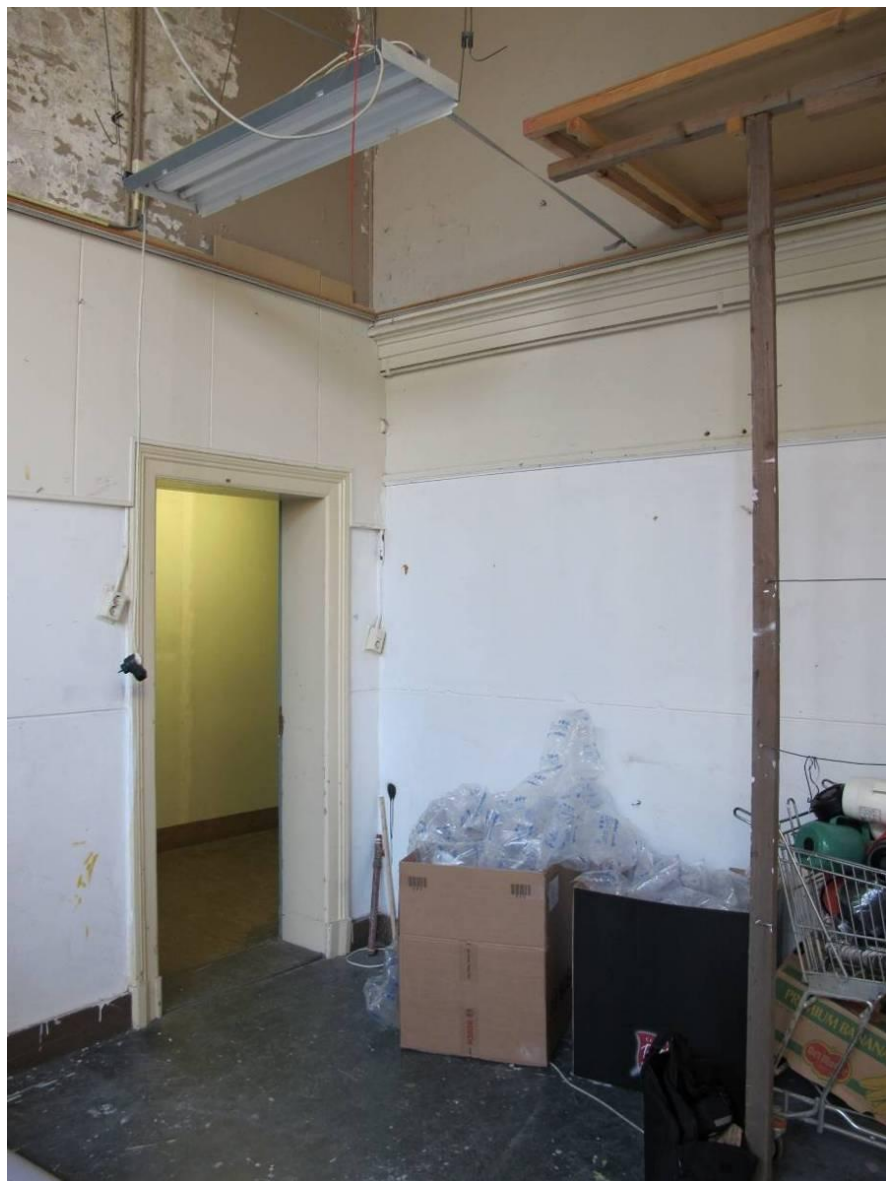
Het lokaal rechtsachter heeft aan de bovenzijde deels een jonge afwerking met gipsplaten. Foto FH MAB 2013
