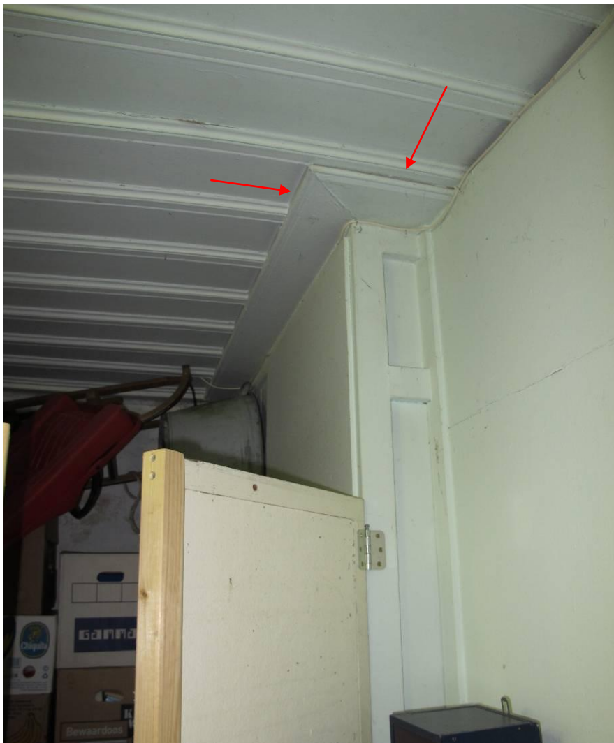
Berging rechtsvoor met doorlopende plafond omlijsting, aangebracht in de jaren '50. Wanneer het een oorspronkelijke omlijsting was dan zouden bij de linker rode pijl de plafondribben onderling verbonden zijn door een aan deze randlijst parallel verlopende lijst. Zie ondermeer bij de foto hiernaast! Foto FH MAB 2013
