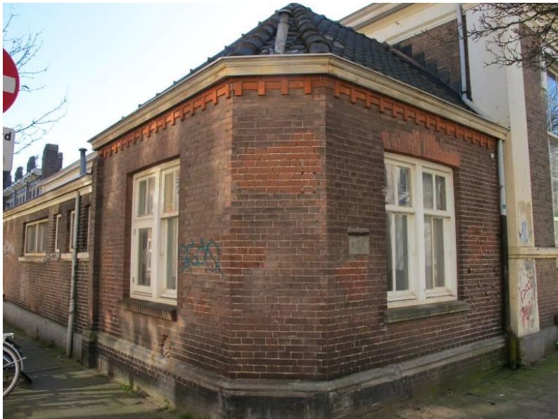
Voorgevel van de linker uitbouw. Foto FH MAB 2013
