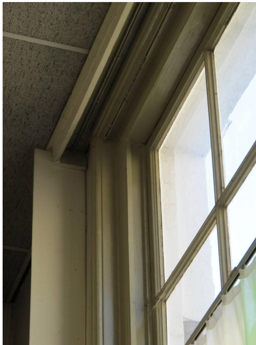
Detail venster voorgevel. Foto FH MAB 2013
