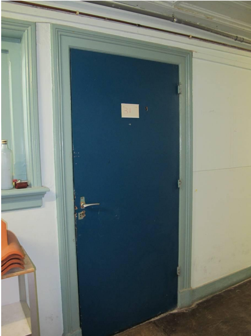
Oorspronkelijke deur naar het derde lokaal rechts is afgeplaat. Foto FH MAB 2013
