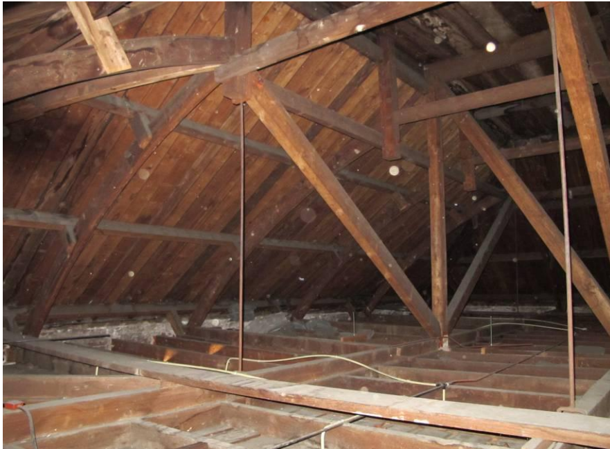
Zicht op de spanten van het achterschild, de laatste afgeschoorde middenstijl en achterste ligger. Foto FH MAB 2013
