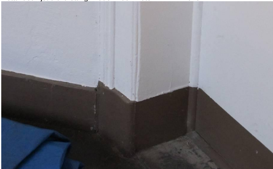
Detail deurlijst dichtzetting middenmuur. Foto FH MAB 2013
