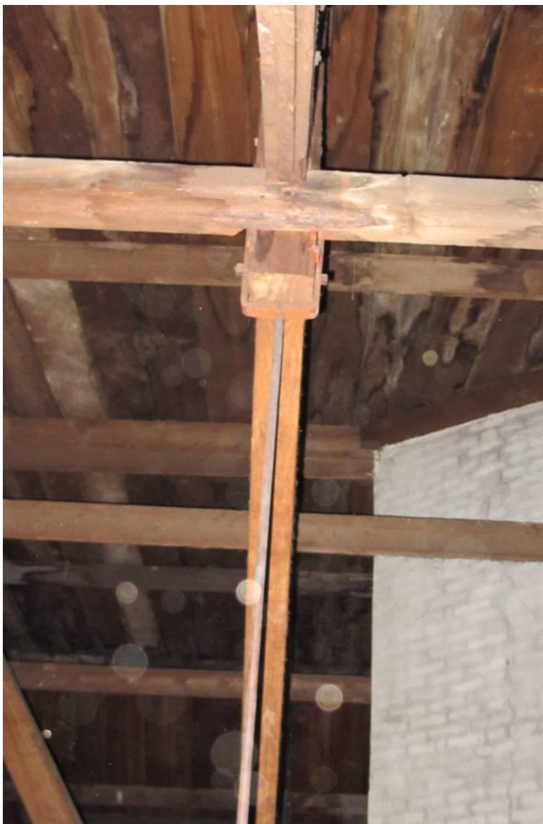
Geboute bevestiging van een trekstang aan een korte stijl. Foto FH MAB 2013
