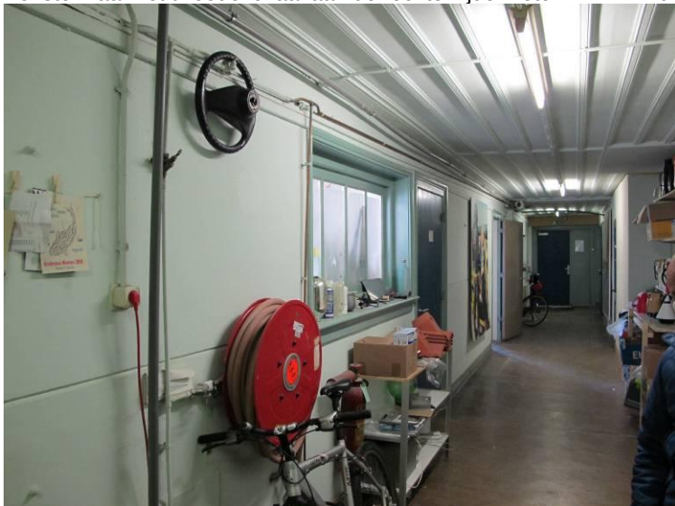
Rechter zijbeuk richting achter met rechts de keep van de lambrisering en het venster naar het derde lokaal. Foto FH MAB 2013
