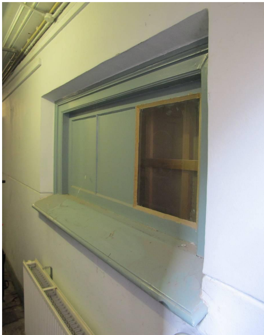
Authentiek venster naar het lokaal rechts achter vanuit de gang met een schuin aflopende onderdorpel. Foto FH MAB 2013
