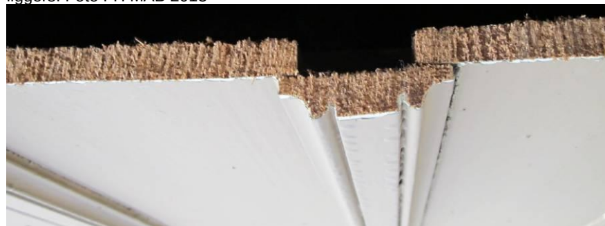
Zicht op de plafondconstructie uit omstreeks 1910. Foto FH MAB 2013
