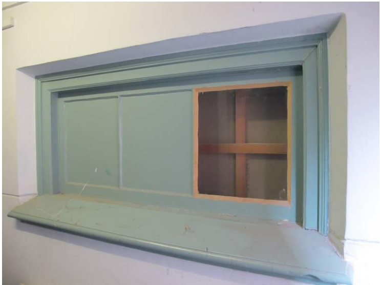
Venster van een lokaal aan de achterzijde met een schuin, aflopende onderdorpel. Foto FH MAB 2013
