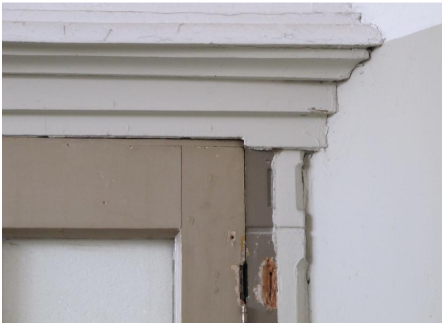
Detail van een bovenhoek van een puiomlijsting met vellingkanten op de stijlen.
