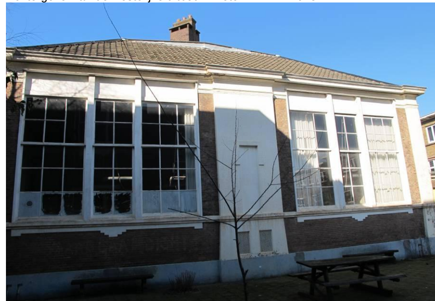
Achtergevel hoofdmassa. Foto FH MAB 2013
