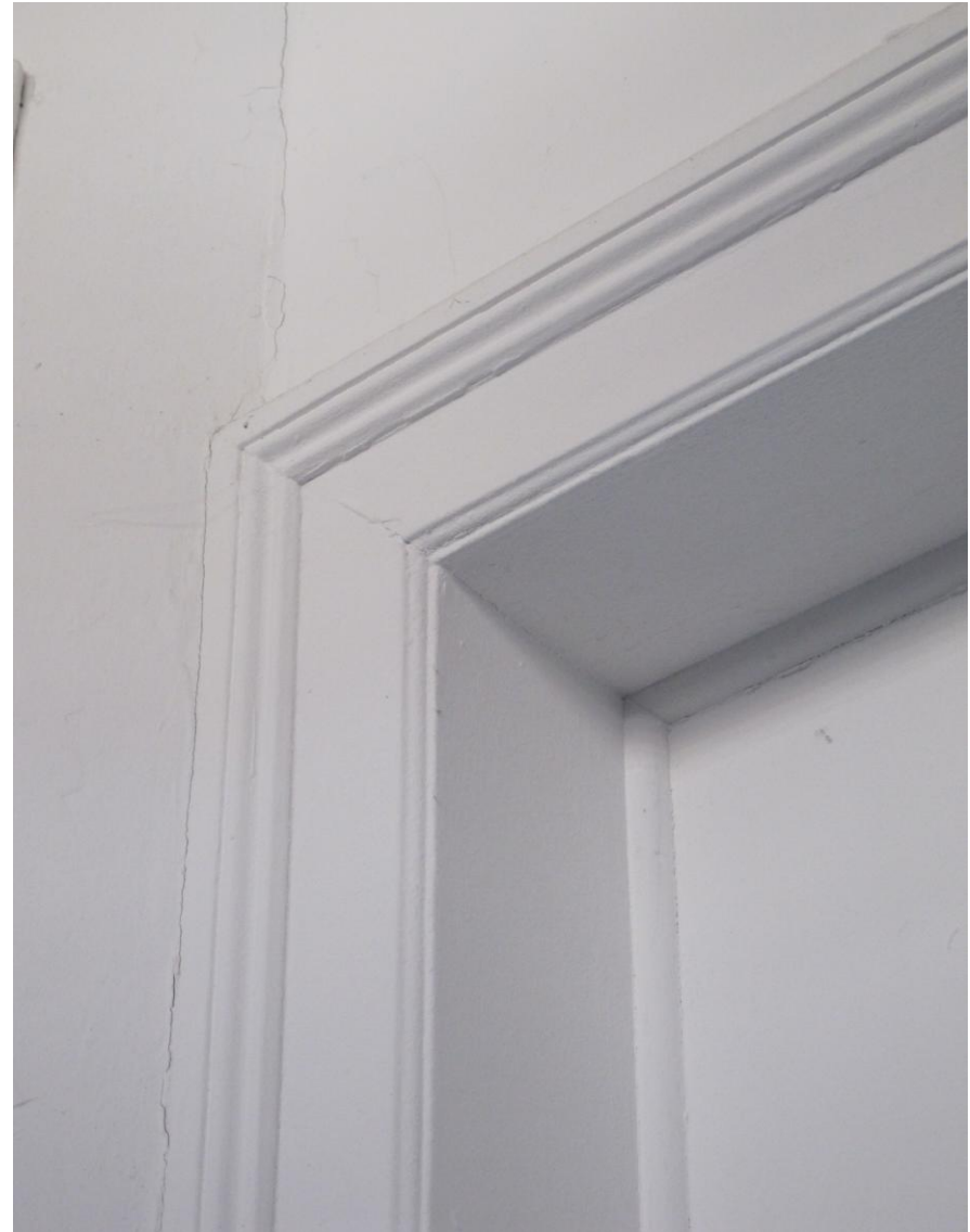
Een kozijn in de scheidingsmuur tussen lokalen in beide beuken met een oorspronkelijke, uit 1876 daterende detaillering.
