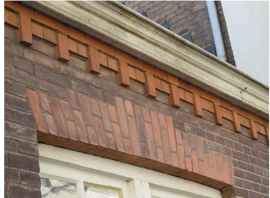
Detail kopgevel oostelijke gang met verblendstenen hanekam en bloktandlijst.
