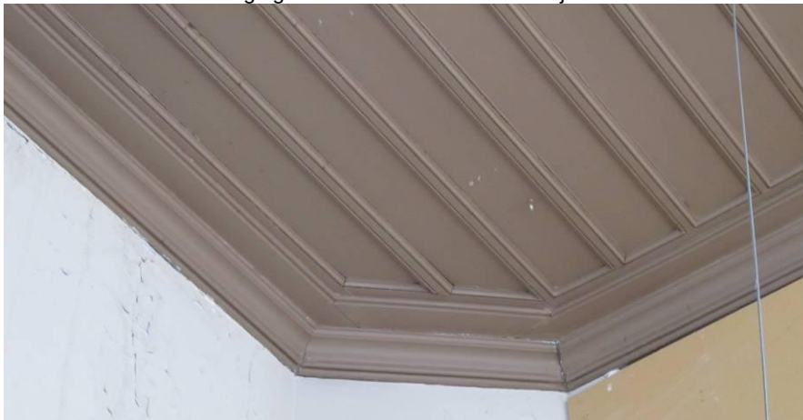
Het plafond uit 1910 in het lokaal rechts achter. Foto FH MAB 2013
