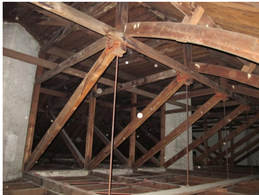
Zicht op de spanten van het oostelijke dakschild, de middenstijlen en afgeschoorde liggers. Foto FH MAB 2013
