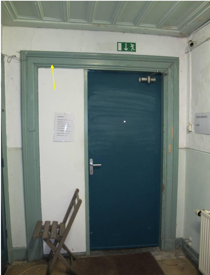
Oorspronkelijk kozijn met jongere buitendeur aan de achterzijde van de linker zijbeuk. Foto FH MAB 2013
