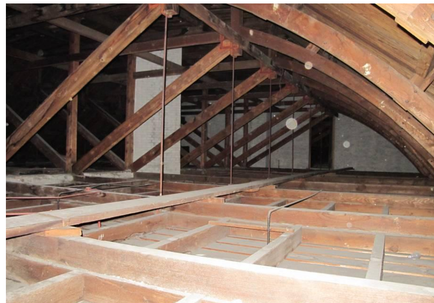
Zicht richting de voorgevel op de spanten van het oostelijke dakschild, de middenstijlen en afgeschoorde liggers. Foto FH MAB 2013
