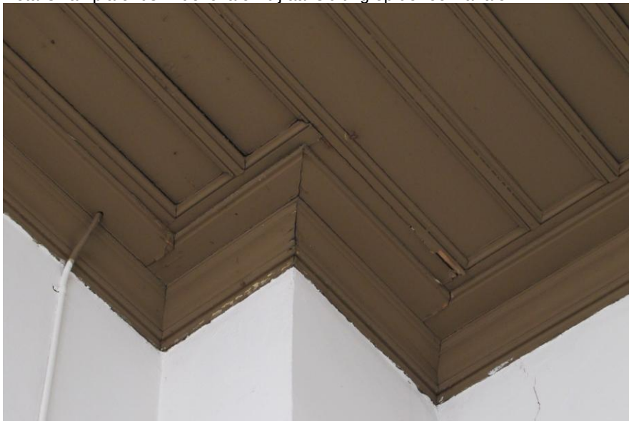
Details van plafonds in de lokalen bij aansluiting op de rookkanalen.
