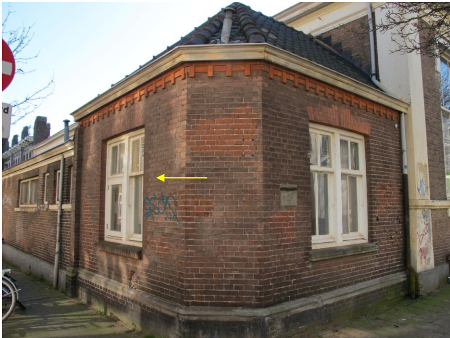
Zicht op de oostelijke zijbeuk met de rond 1910 verbouwde en verhoogde voorbouw die een eigen schilddak kreeg. In de linker zijgevel werd in de jaren '50 een nieuwe vensteropening ingebroken met strek en bakstenen lekdorpel en ingekaste dagkanten(gele pijl). Foto FH MAB 2013
