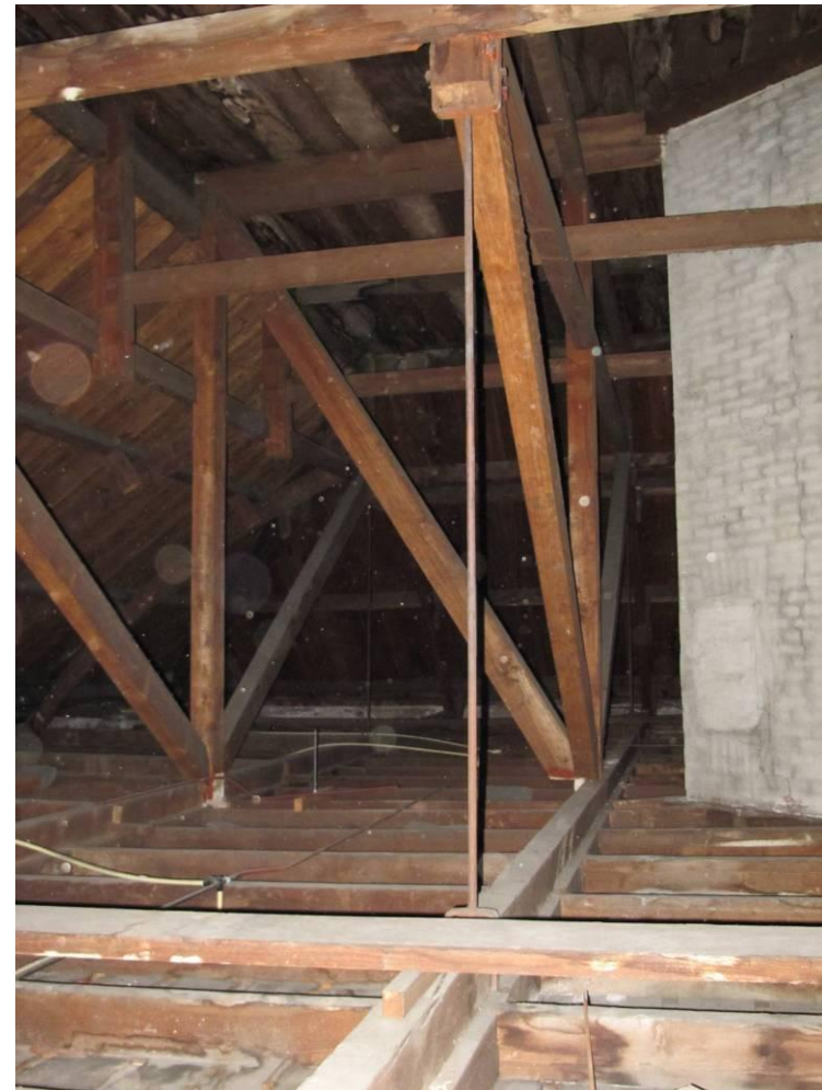
Zicht op de spanten van het achterschild en de laatste afgeschoorde middenstijl. Foto FH MAB 2013
