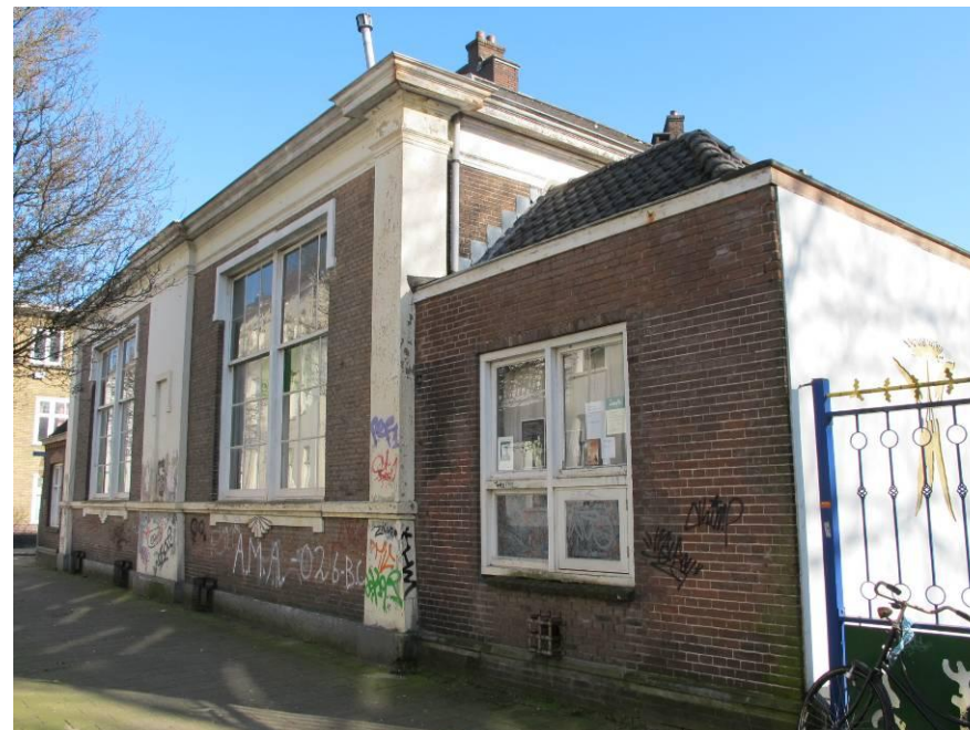
Voorgevel vanuit het westen. Foto FH MAB 2013
