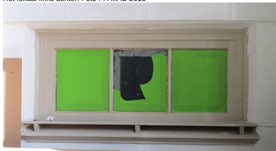
Authentiek venster in het lokaal links achter met een schuin aflopende onderdorpel. Foto FH MAB 2013
