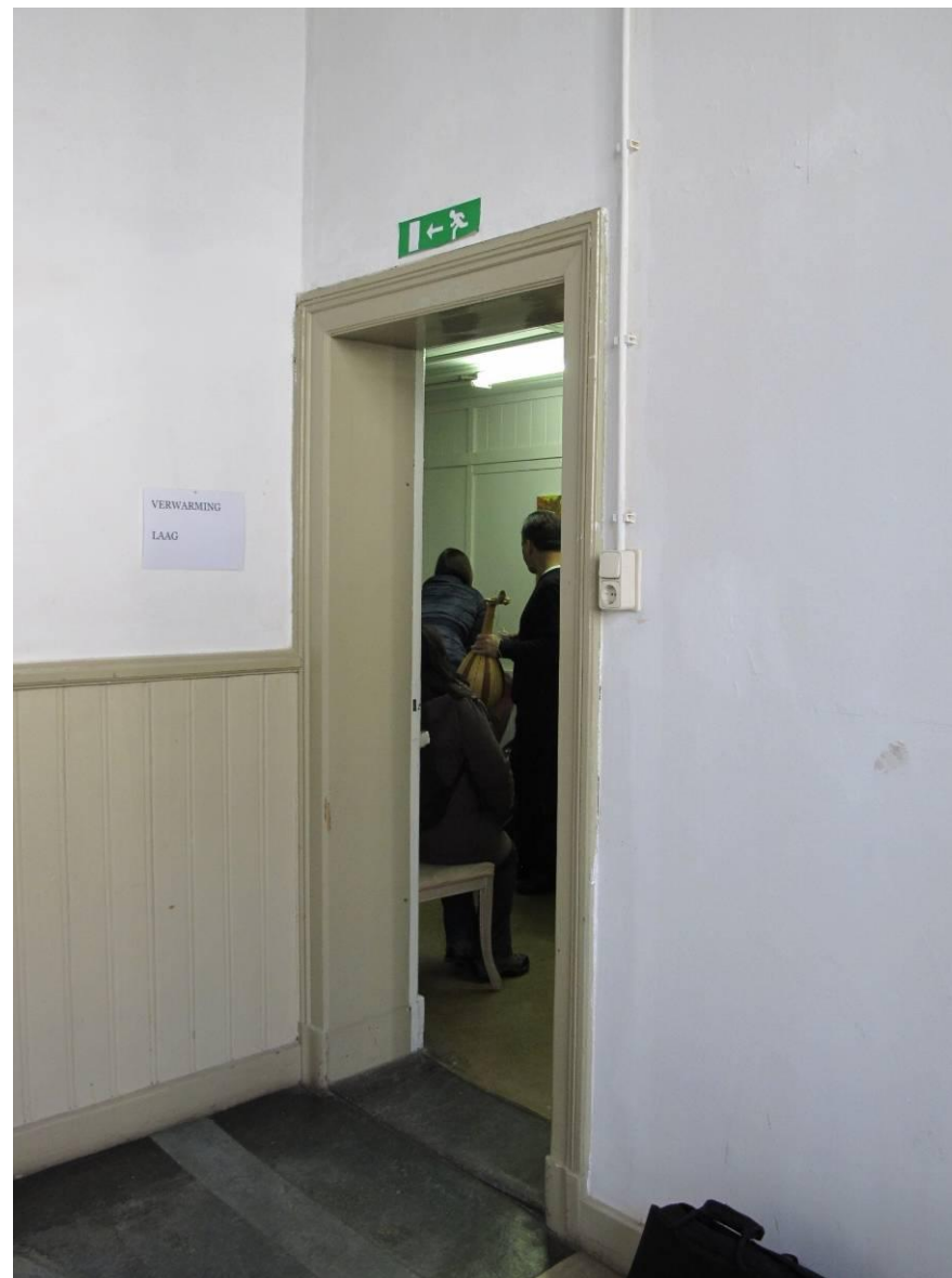
Oud kozijn van de toegangsdeur van het lokaal rechtsvoor. Foto FH MAB 2013
