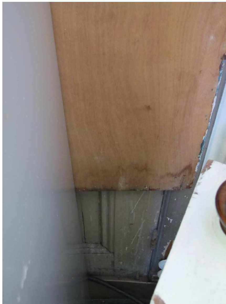
Afgetimmerde deur uit 1876 in de middenmuur van de tweede lokaal rechts. Foto FH MAB 2013
