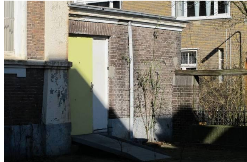
Achtergevel van de oostelijke uitbouw. Foto FH MAB 2013
