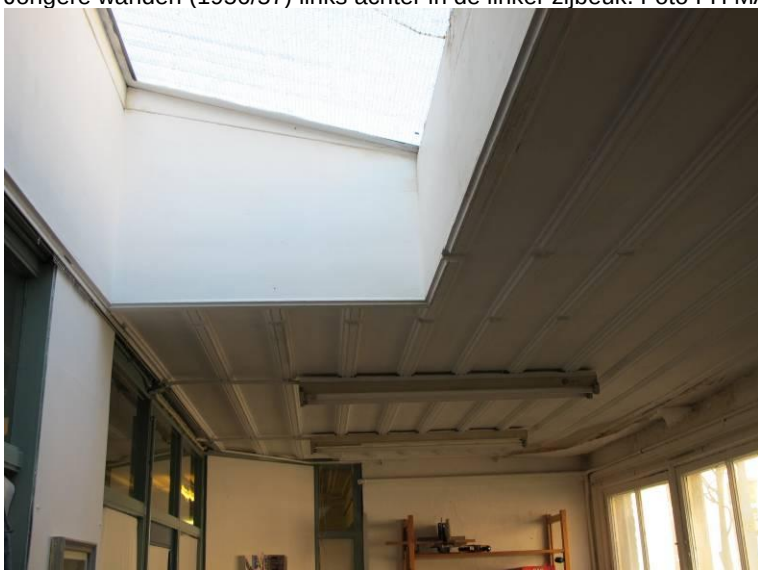
Plafond ruimte links achter toiletblok in de linker zijbeuk met aansluiting daklicht. Foto FH MAB 2013
