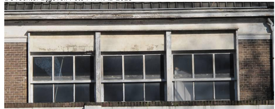
Venster in de rechter zijgevel. Foto FH MAB 2013
