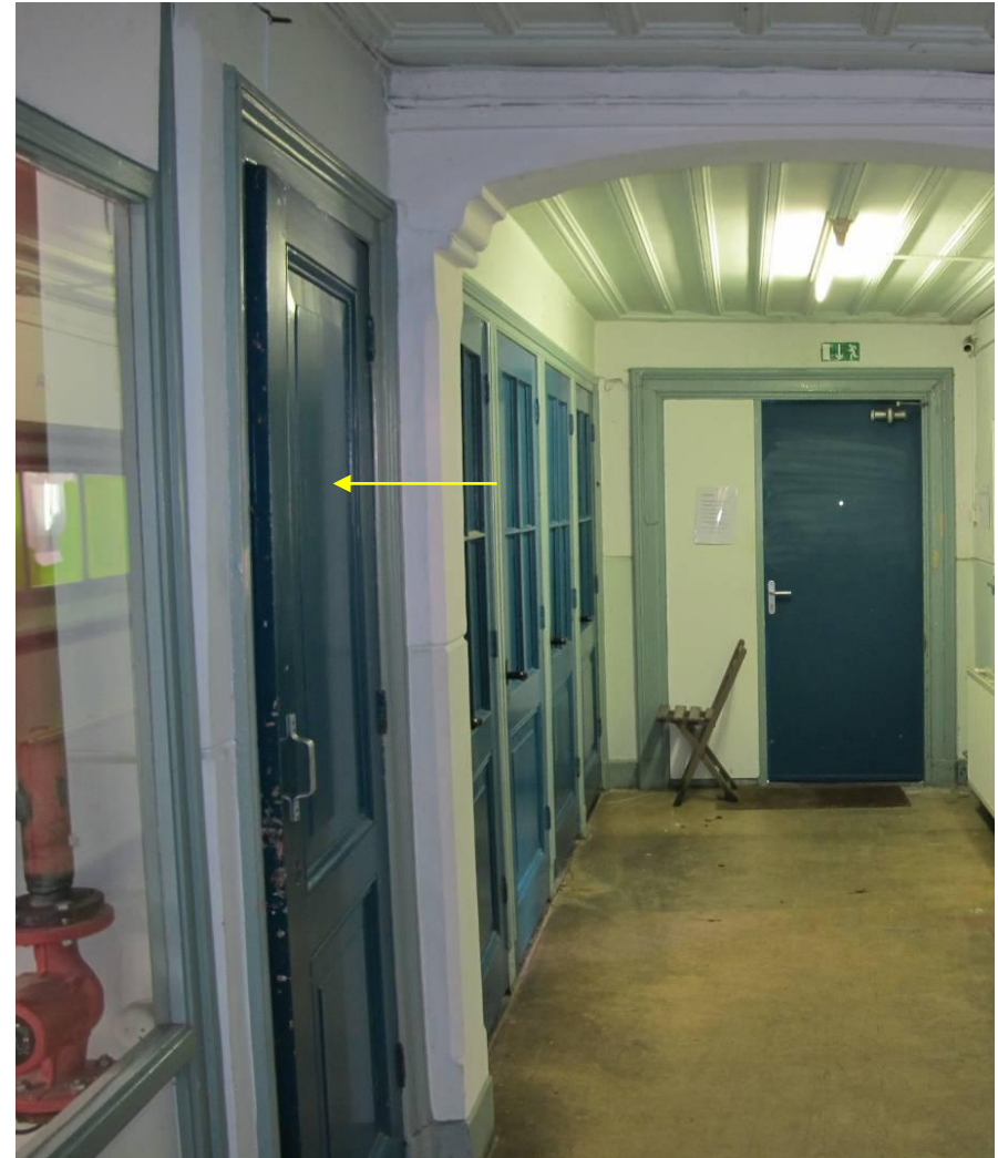
De afwijkende deur (gele pijl) aangebracht in 1910 toen men bij herschikking van de toiletten hier een vijfde toilet toevoegde is mogelijk een van de oorspronkelijke achterdeuren. Foto FH MAB 2013
