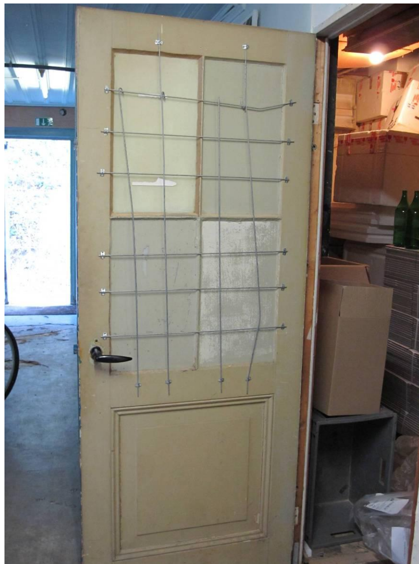
Oorspronkelijke deur in de nieuwe inbouwwand van de berging rechts achter in de rechter zijbeuk. Foto FH MAB 2013
