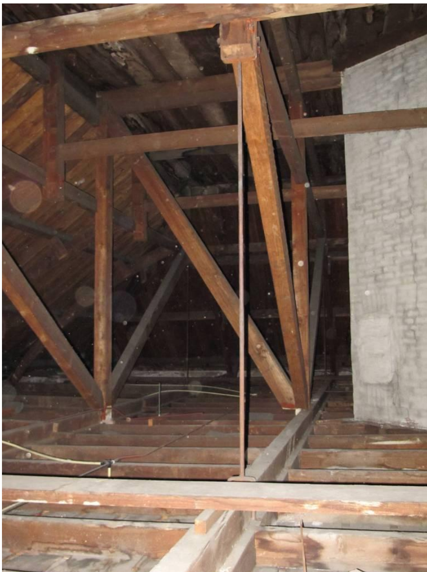
Zicht op de geboute, stalen, trekstang van de dakconstructie. Foto FH MAB 2013
