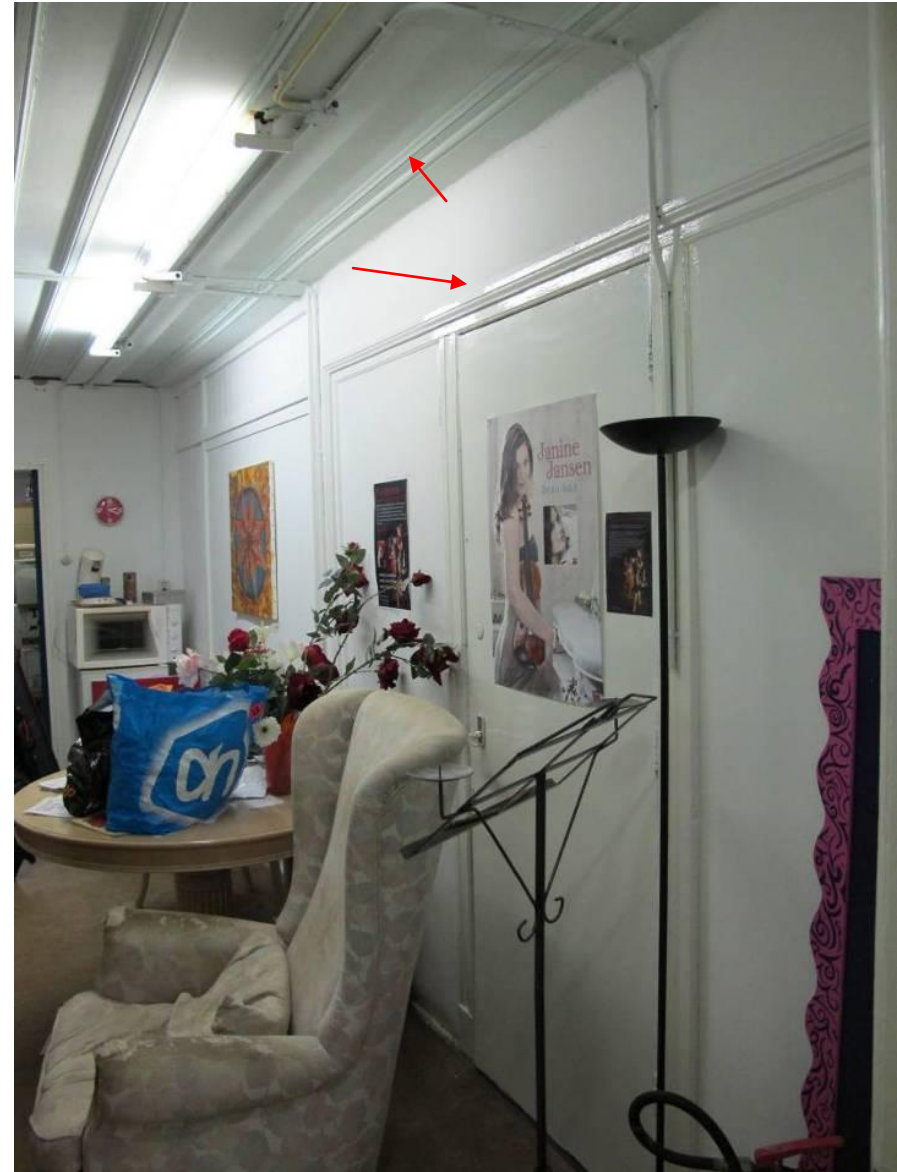
Oud kozijn in de wand van de berging en een doorlopende lijst langs de bovenzijde van de wand. Foto FH MAB 2013
