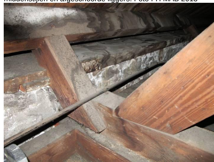
Aansluiting kap op oostgevel. Foto FH MAB 2013
